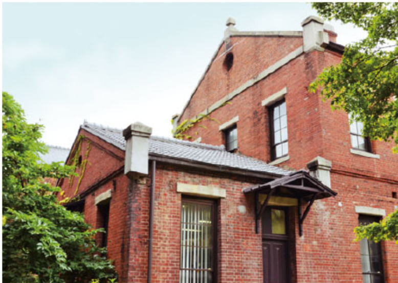
図書室本館は1870年代の旧京都織物会社の赤煉瓦建築を転用している 開室時間：月曜日～金曜日 9:00～17:00
