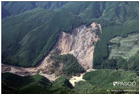
深層崩壊の例
