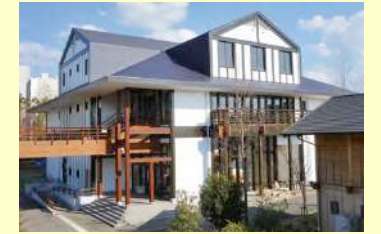
木質材料実験棟
